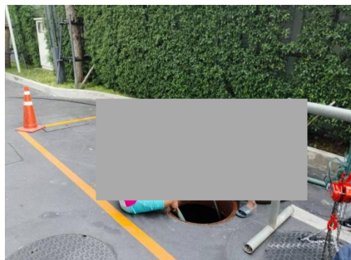
รูปที่ 2-46 การสูบตะกอนของระบบบำบัดน้ำเสีย
