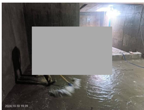
รูปที่ 2-44 การล้างทำความสะอาดถังเก็บน้ำ ประจำปี 2567
